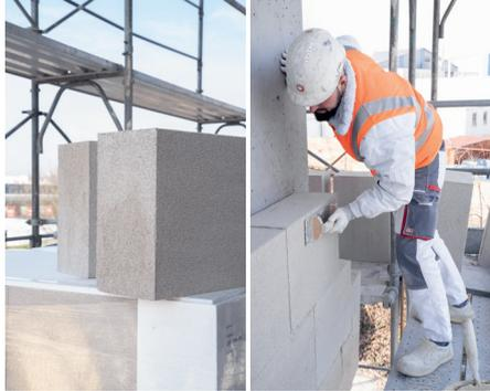
Zirkuläre Dämmstoffe mit Schweizer Rohstoffen aus dem Rückbau (swisspor AG)
